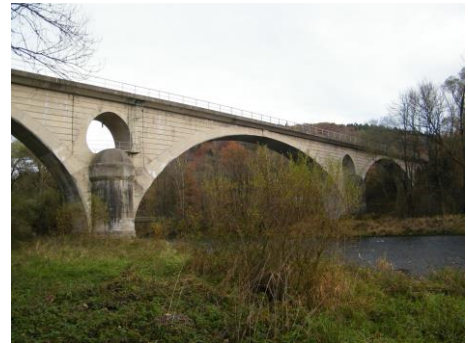
Eisenbahnbrücke, Garching a.d. Alz
